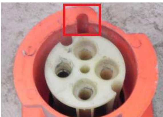
Encaixe do pino guia na tomada
